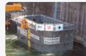
浮体式仮締切設備(鶴田ダム)
