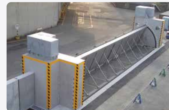
陸上設置型フラップゲート式 可動防潮堤 neo RiSe®
