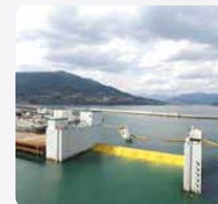
浮体式仮締切設備(鶴田ダム)
