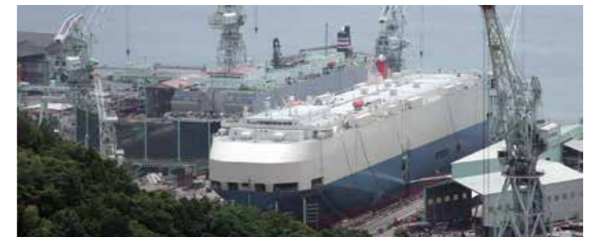
3号ドック No.3 dock
