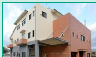
汚泥再生工場
