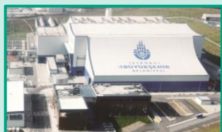
ごみ焼却発電施設
