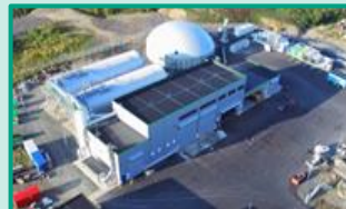
バイオガス工場
