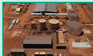
排水処理施設
