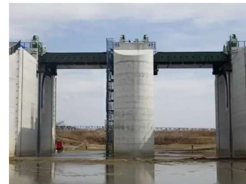
図A-1-11：長島水門(横転式ローラーゲート)
