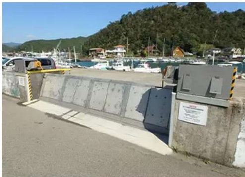
図A-1-12：陸上設置型フラップゲート式可動防潮壁
