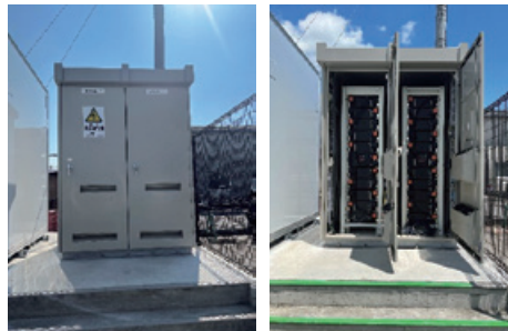
佐賀県小城市役所オフグリッドシステム向け リン酸鉄リチウムイオンバッテリーユニット
