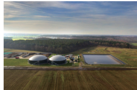
バイオガスプラント
