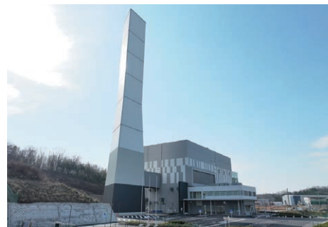
枚方京田辺可燃ごみ広域処理施設（京都府京田辺市）
