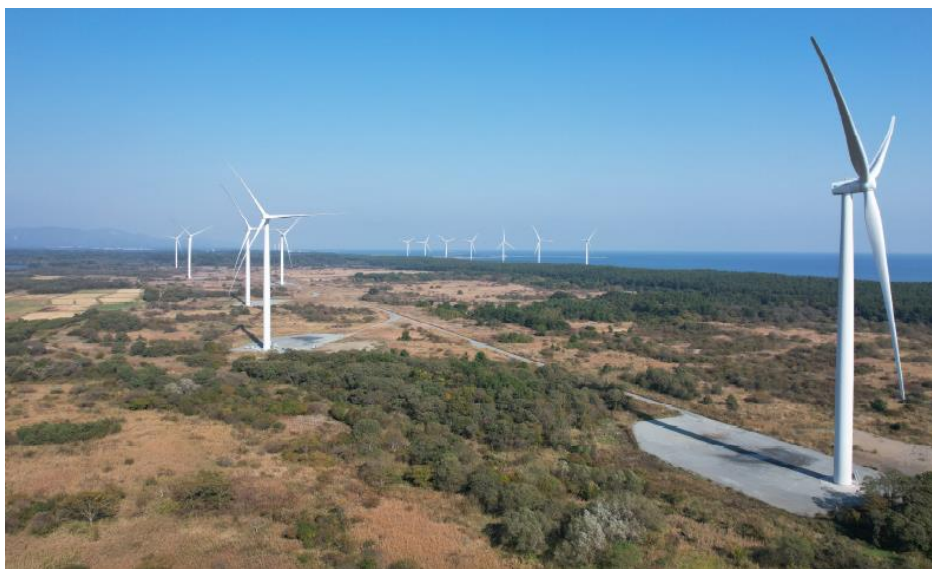
【青森県上北郡六ヶ所村で完工した陸上風力発電所】
