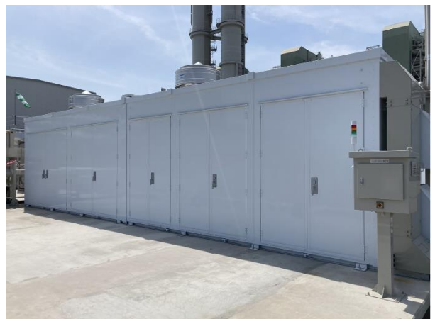
【当社納入の水電解装置 (提供：関西電力)】
