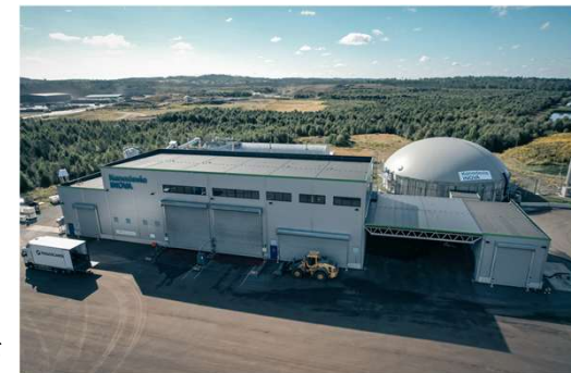
図A-2-1-3：バイオガスプラント
