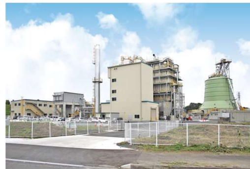
図A-2-1-2：木質バイオマス発電プラント
