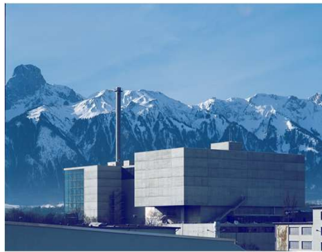
図A-2-1-1：ごみ焼却発電施設
