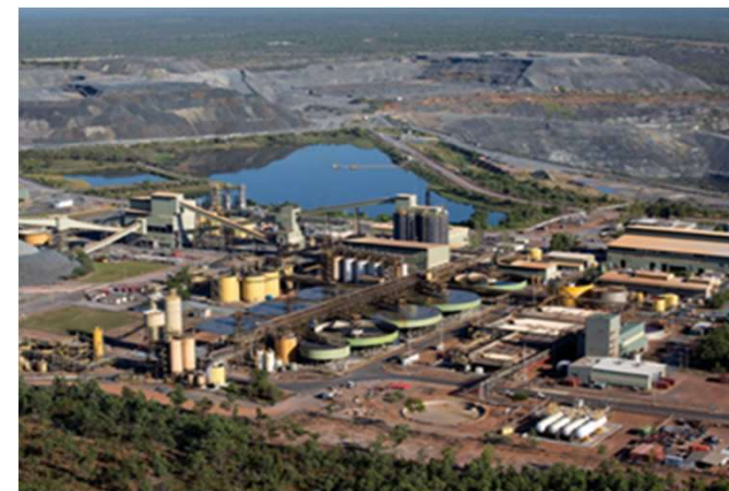
図4-6：Ranger Uranium Mine 排水処理施設等
